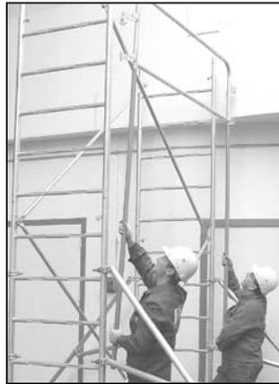
Les garde-corps longitudinaux lg 1,50 m peuvent également être monté du niveau inférieur à l'aide des monte garde-corps.
