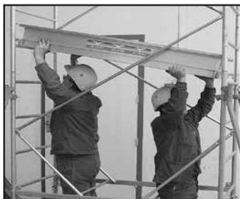
3 - Mettre en place le plancher sur le barreau le plus haut de l'échelle 1,50 (5 barreaux), verrouiller les sécurités anti-soulèvement.
