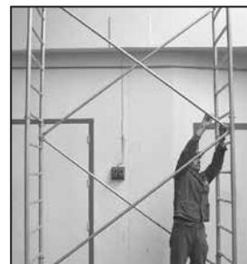
3 - Mettre en place le plancher sur le barreau le plus haut de l'échelle supérieur 1,50 (5 barreaux), verrouiller les sécurités anti-soulèvement.
