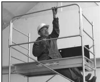
4 - Depuis l'intérieur du plancher mettre en place les garde-corps longitudinaux, crocheter les cavaliers sur les barreaux de l'échelle d'extrémité.
