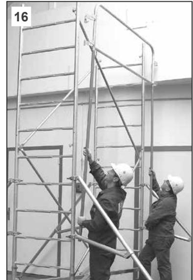
Une fois le garde-corps en position n'oubliez pas lors de l'accès sur le plancher de verrouiller la sécurité anti-soulèvement. (photo 17, 18 et 19).
