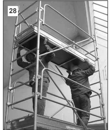
**10** - Pour le dernier niveau, Hisser et installer les échelles de faites (garde corps d'extrémité) (photos 29 et 30). Puis du niveau inférieur remonter les garde corps en haut des échelles de faites (photo 31). Crocheté à l'échelle remonter le plancher à son niveau définitif, 1,00 m en dessous de la lisse supérieure du garde corps (photo 32).
